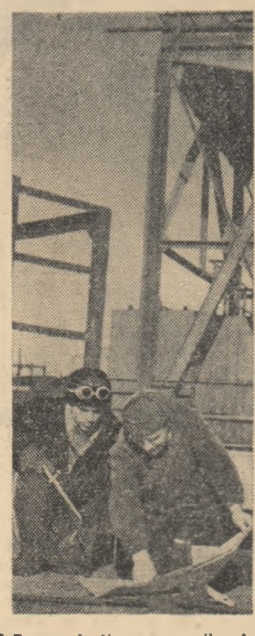
Pe unul din cargourile în lucru, la Șantierul naval Galați, comunistul Vasile Stanilă; se ocupă în permanență de creșterea calității tinerilor muncitori. Iată-l împreună cu sudorul T. Nicolae urmînd planul construcției unui nou cargou. Foto: AGERPRES
