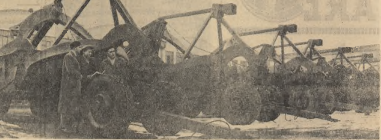
Uzinele metalurgice „Unio” din Satu Mare, regiunea Maramureș. În fotografie: comuniștii ing. Vasile Suciu, șeful secției a două lăcășuri-montaj împreună cu ministrul lăcășului Ural Carol și utemiștul Teodor Boroboc, controlor de calitate, recepționează un nou lot de troluri, scoperă de 6 m.c. necesare agriculturii.
