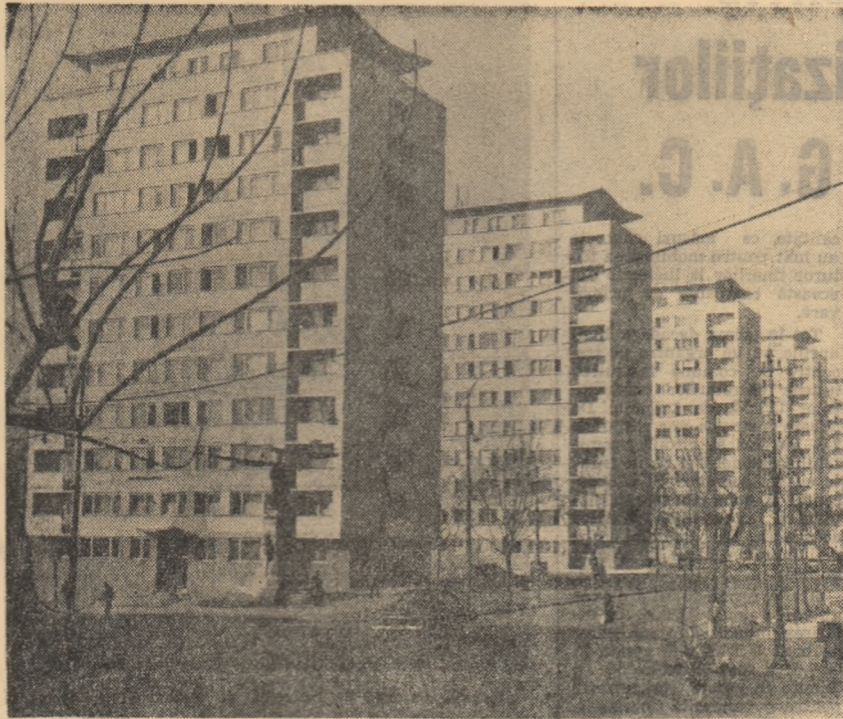
Noi blocuri în apropierea Gării de Nord.
