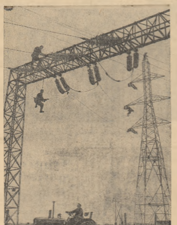
Se montează o nouă linie de înaltă tensiune. Foto: E. POPPER
