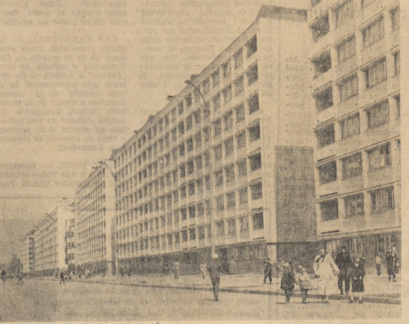
Vedere generală de pe noua magistrală Nord-sud care se construiește în București. Foto: C. BUȘOIU
