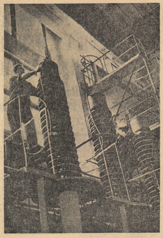
La uzina „Izolator” din Moscova unde se construiesc racorduri de 220.000 de volți. În fotografie: asamblarea unui racord.
