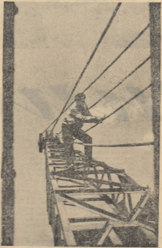
Control de mare precizie. Tănuș C. Paul de la Trusil de reparații aliaz greu din Capitală execută înălțimea curentii la scarașorul mareș.
