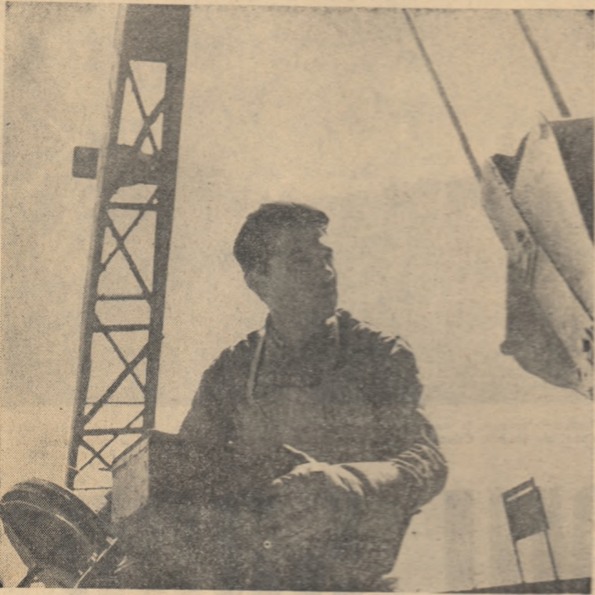
În acest an, la șantierul „Mai” din Băila s-a edificat sudura automată. Ea contribuie la obținerea unei producții sporite, la o calitate superioară a sudurii. Buna Gheorghe este curajul pe șantier pentru lucrările de bună calitate și pentru economiile pe care le realizează.
