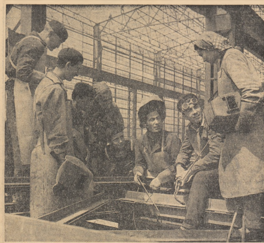
Comunistul Zecus Ion, de la Întreprinderea de construcții siderurgice-Hunedoara, explică unui grup de elevi-sudori, modul de îmbinare prin sudură în unghi a formelor pentru acoperșul unei hale
