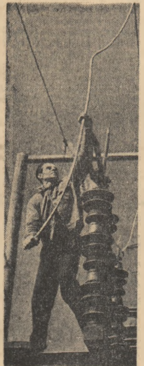
La stația de transformare a energiei electrice Titan din Capitală se fac instalații de noi transformatoare. Iată în montaj Ion Cercel lucrînd la o asemenea instalație.
