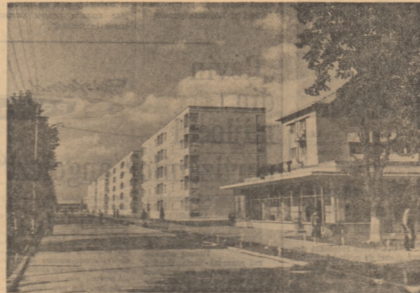
Noi blocuri imnicioare pe strada Anton Pam din orașul Roman.
