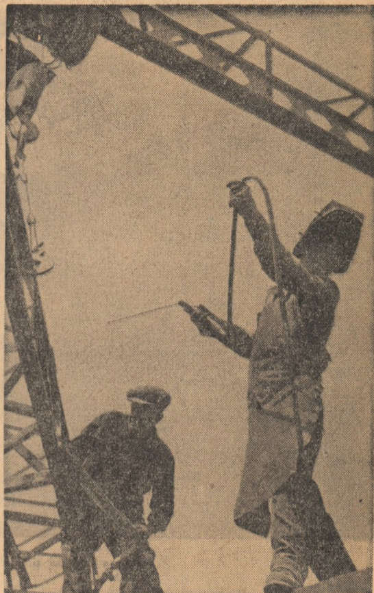
Întreprinderea de Poduri Metalice și Prefabricate de Beton-Pitești. În secția mecanică de confecționare a stîlpilor pentru linii de înaltă tensiune. Sudorii lucrează la finisarea stîlpilor metalici.
