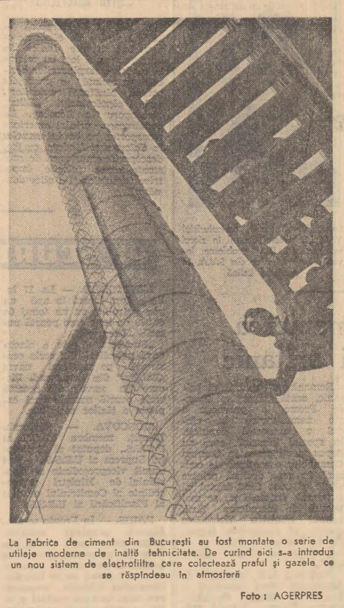
La fabrica de ciment din București au fost montate o serie de utilaje moderne de înaltă tehnicitate...
