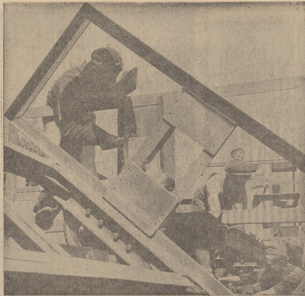
Sudorii și montorii Uzinelor „Unio” din Săul Mare lucrează la scheletul vagoanelor...
