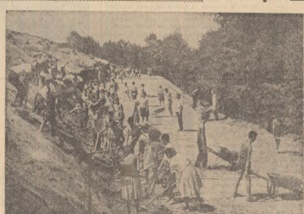
În luna iulie s'a deschis la Brașov un șantier pentru construirea unui nou drum ce va lega orașul cu Poiana Brașov. La lucrările acestui șantier contribuie însemnat o aduc tinerii din oraș. Pînă în prezent ei au efectuat la acest șantier 35.500 ore muncă patriotică. În fotografie: brigăzi de tineret lucrînd pe acest șantier.
