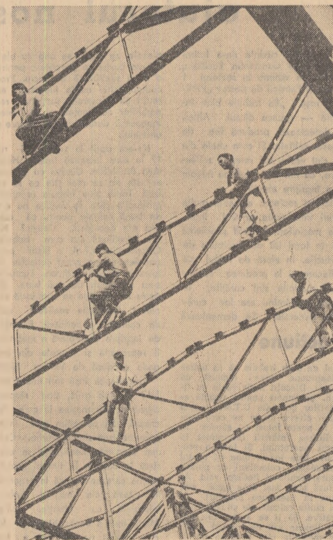
Constructorii pe schele Foto: N. STELORIAN
