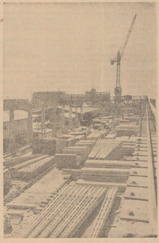
Aspect general al depozitului întreprinderii de prefabricate și materiale de construcții Constanța.
