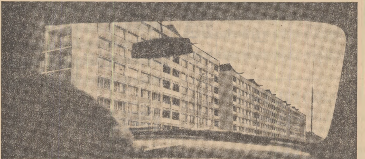
Aspect al noilor blocuri construite pe magistrala Nord-Sud din Capitală.
