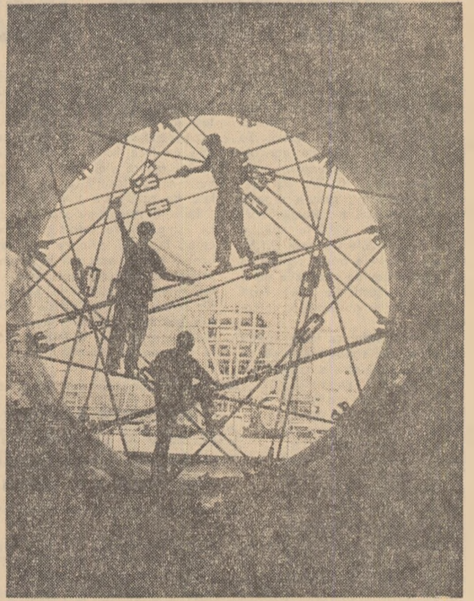
U.R.S.S.: Pe șantierul noii fabrici de ciment din Balakli (regiunea Harkov) lucrările de montare a scheletului metalic al cupturilor rotative a căruia lungime este de 185 m sînt într-un stadiu avansat. La această fabrică vor funcționa 4 cupatoare de acest fel. Foto: TASS-Moscou
