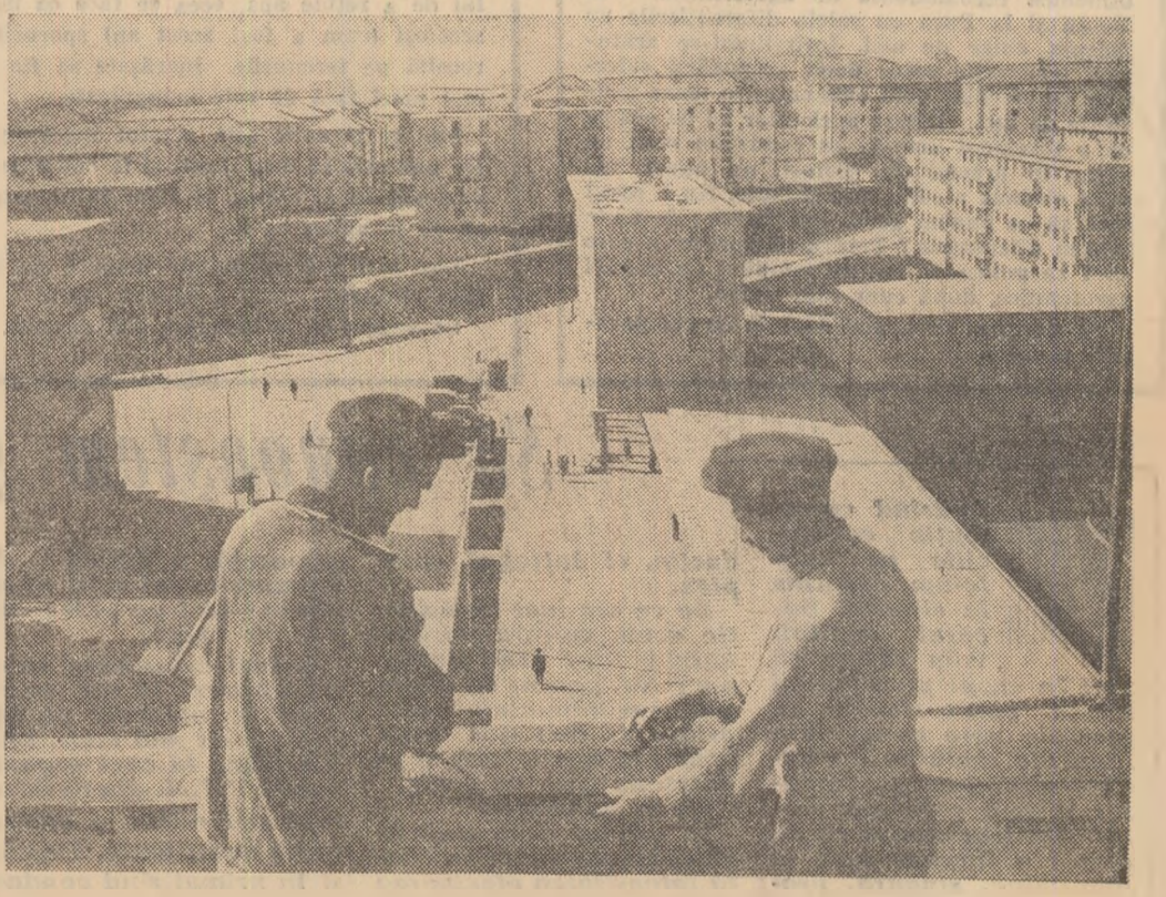
Construcții noi la Onești, regiunea Bacău
