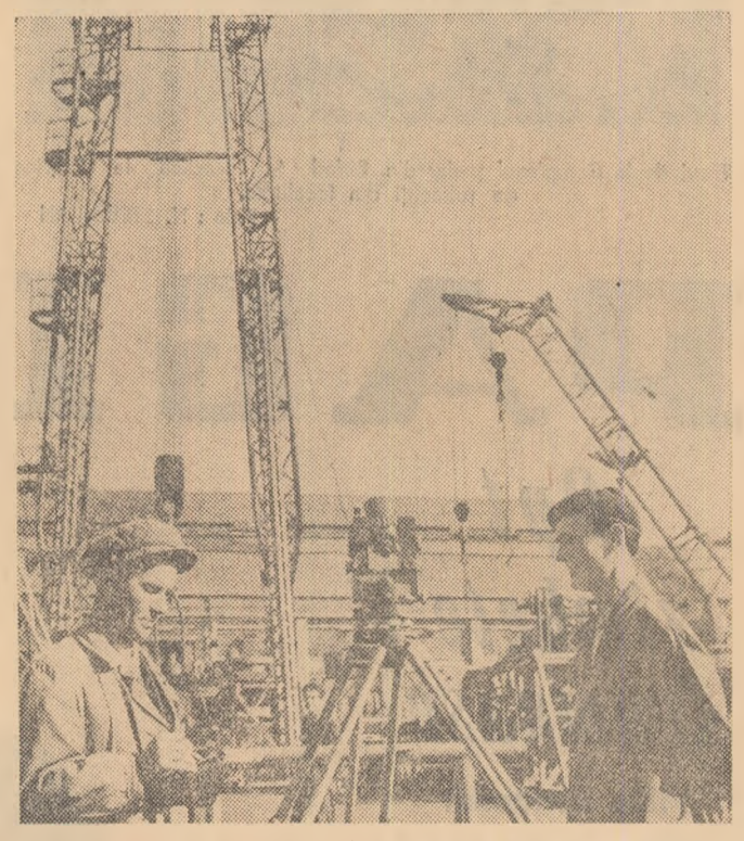
Instalația de foraj 4 L.D. a adus colectivului Uzinelor „1 Mai” din Ploiești laude bine meritate. Fotografia noastră reprezintă momentul cînd inginerul Vladimir Vasilescu și maestrul Constantin Tomescu controlează centrarea turlei instalației.
