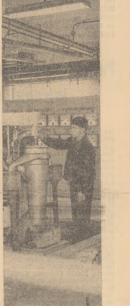
Fabrica de ulei „Interindustrial” din Oradea. Tînarul Nicolae Igna, ajutor centrufigur, urmărește funcționarea automată a unor instalații din secția de rafinare a uleiului.
