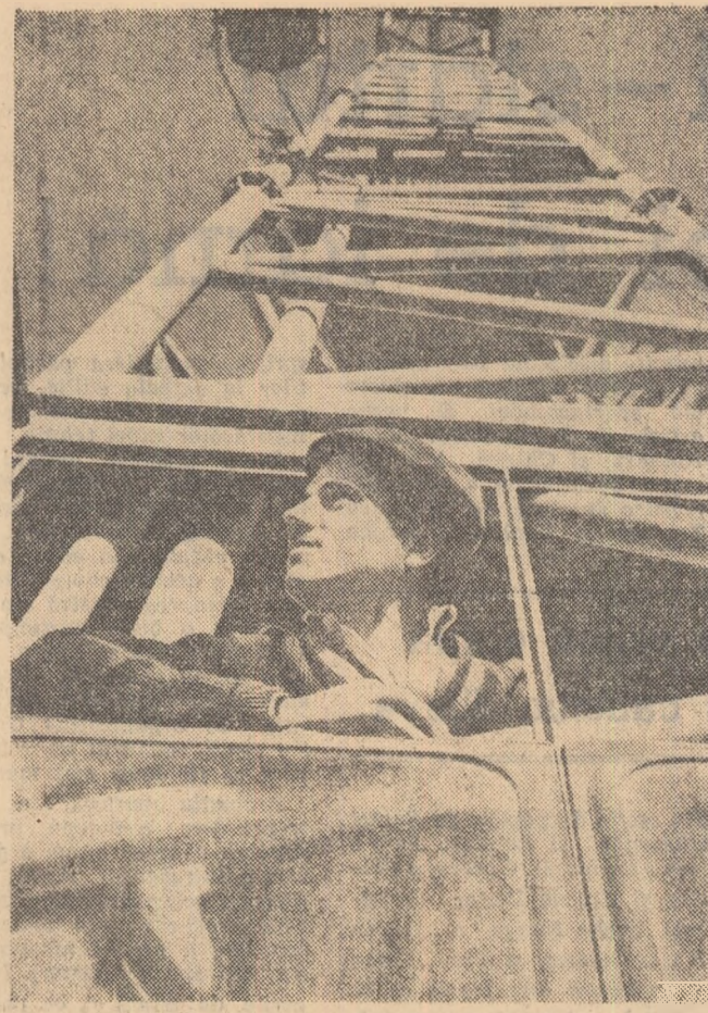
Macaragiul Ciobanu Florea este fruntaș pe șantierea blocurilor de locuințe din Calea București, orașul Craiova. Datorită unei bune organizări a muncii, a întreinerii utilajului în perfectă stare el reușește să asigure materialul necesar construcțiilor, la timp
