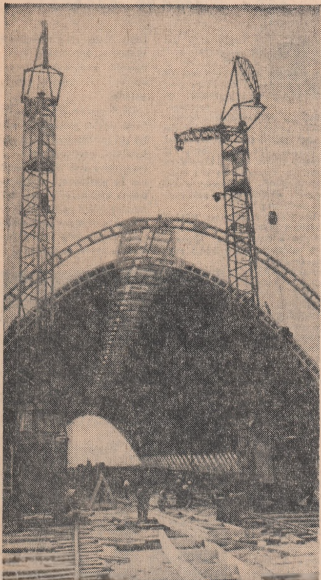
Aspect al șantierului de construcție a Combinatului metalurgic din Slovacia de vest unde se lucrează la noul hală auxiliară a secției de furnale.
