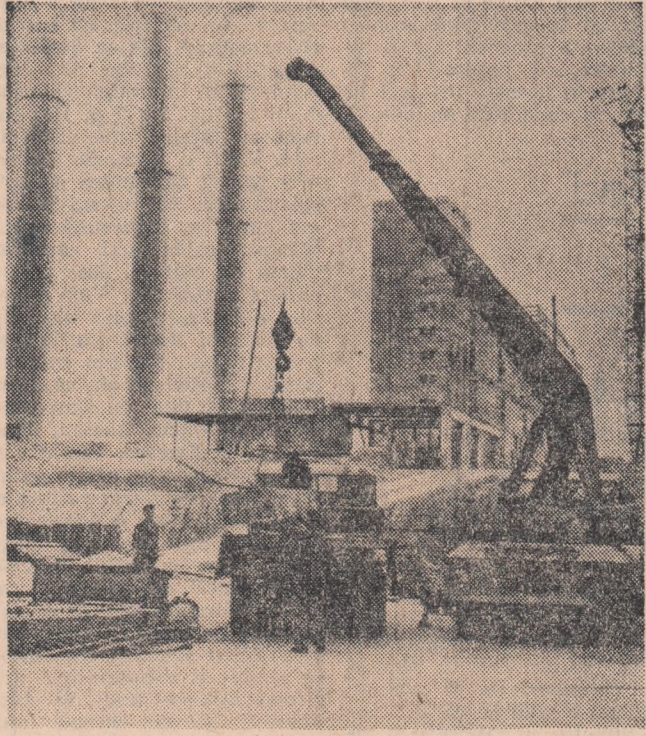
Pe șantierea de construcție a formozentei de la Velschau din R.D. Germană.
