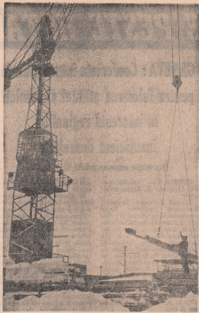
Întreprinderea de prefabricate „Progresul” din Capitală. Se manevrează stâlpii pentru iluminatul public în vederea expediției lor
