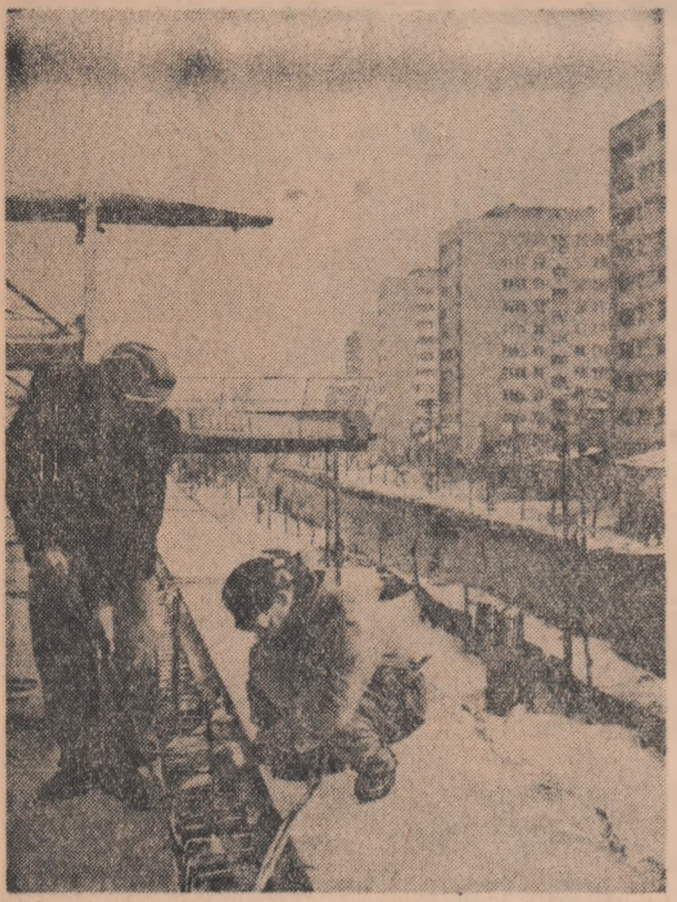
În plină iarnă, pe șantiierul lucrărilor de locuințe de bulevardul „1 Mai” din Capitală înfățișăm fragmentul specific muncii constructorilor. În fotografie: aspect din activitatea muncitorilor armatori de la noile blocuri din prefabricate aflate în construcție.
