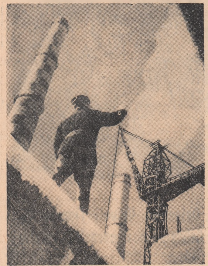
Pe șantierul de construcție a termocentralei din Verhne Taghil, regiunea Sverdlovsk. Această termocentrală este unul din cele mai mari agregate ale sistemului energetic Ural
