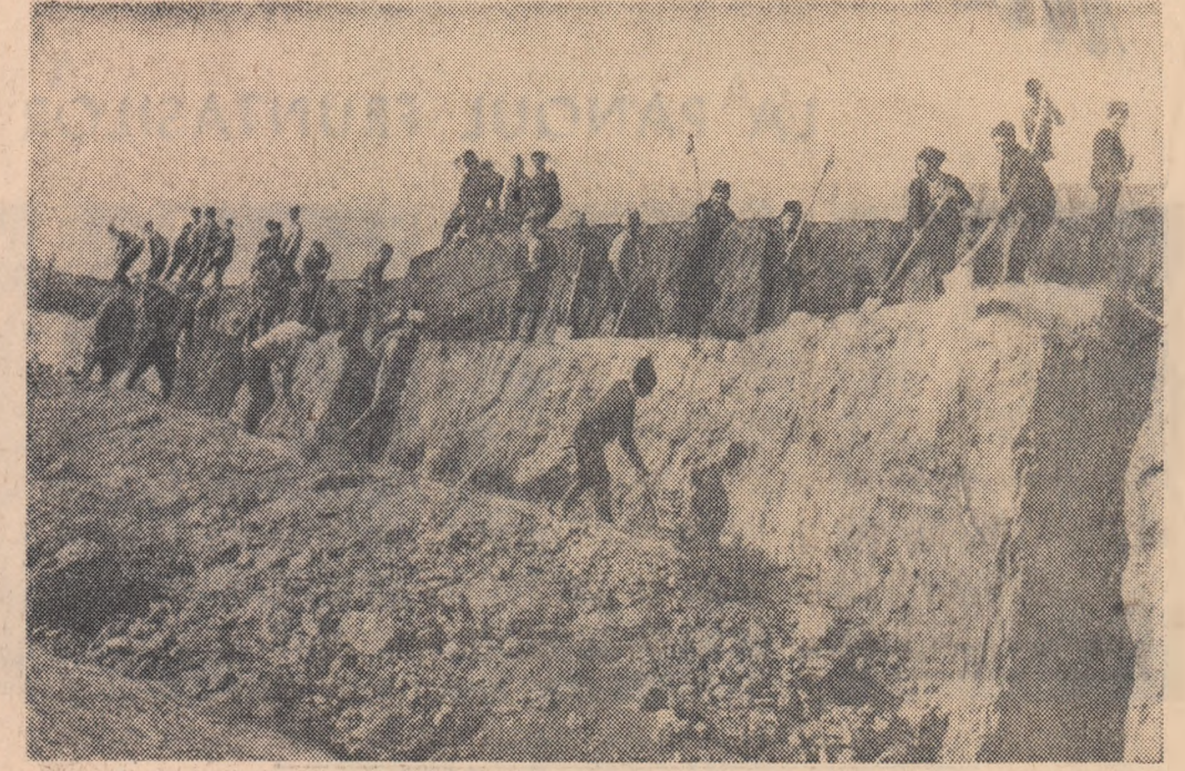
Colectivii din Cătrunești, raionul Urziceni, pun în valoare o nouă sursă de venituri pentru dezvoltarea averii obștești. Prin construcția unui dig vor amenaja un iaz de 14 hectare care va fi populat cu pește. Apele de aici vor fi folosite și la irigația unei suprafețe de 100 de ha de grădini și cultură de cîmp. Foto: I. CUCU
