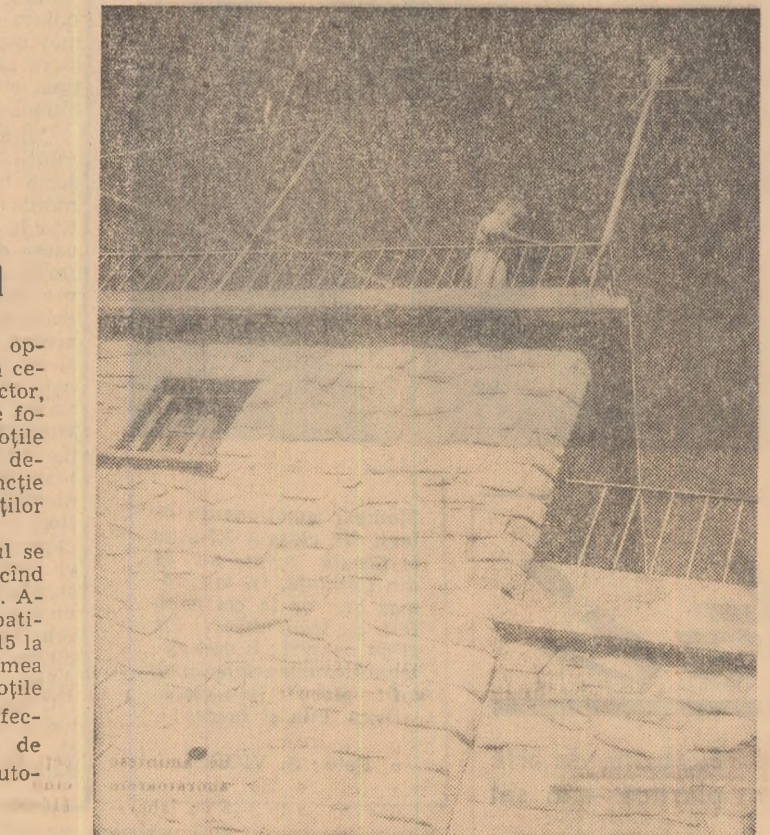
Noua construcție care adăpostește stațiunea meteorologică de pe vîrfu „Omul”
