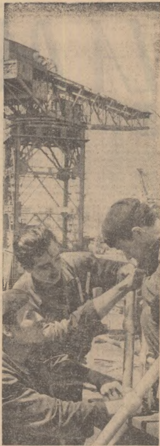
Santierul naval Galați. Tinerii montori Gheorghe Sava, Cristian Dragomir și Radu Drăgusanu fac o ultimă verificare a lucrărilor executate de ei la un nou catarg de 4500 tone, lansat de curînd la apă.
