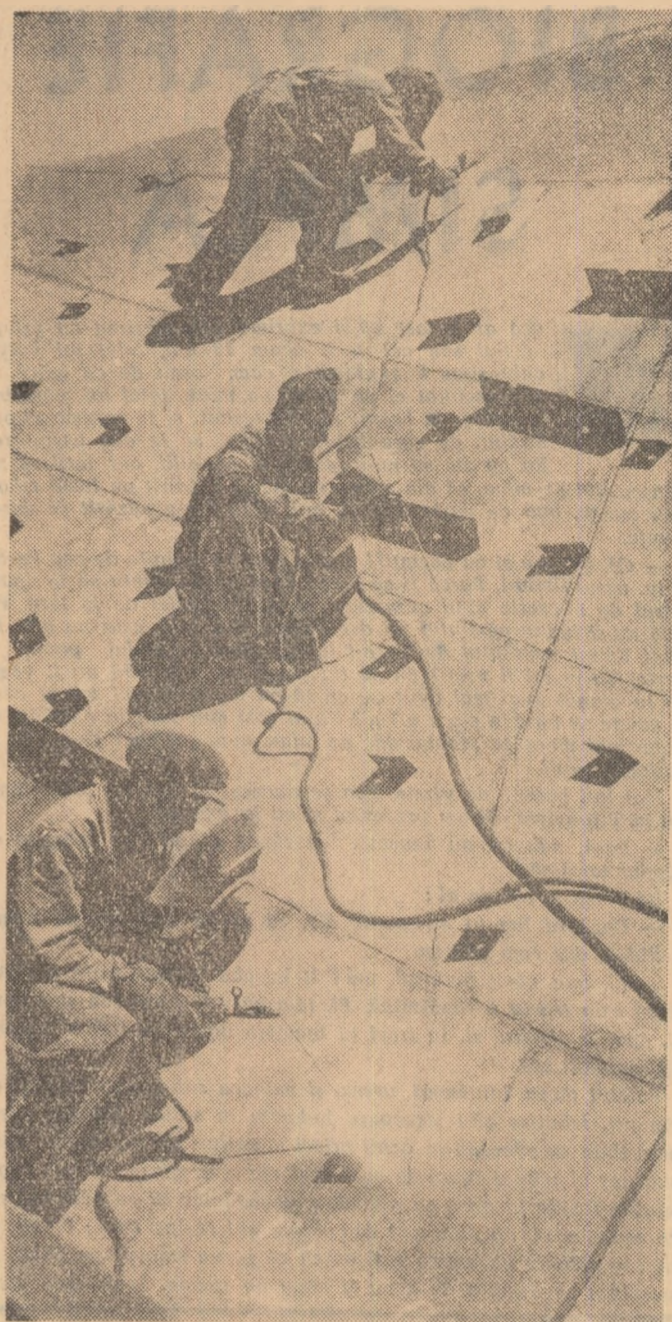
O lucrare de asamblaj-montaj pe șantierul naval Galați.
