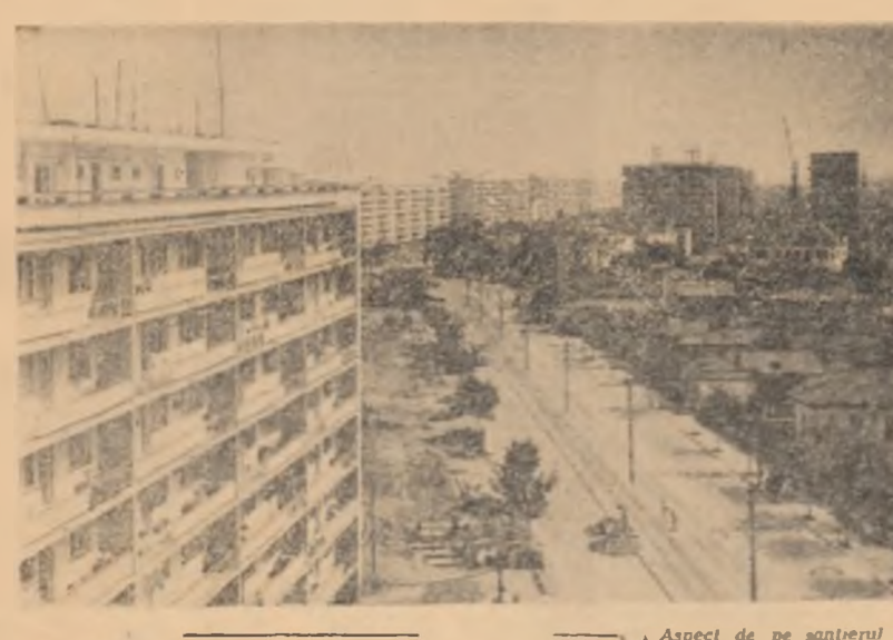
Aspect de pe șantierul de construcții de locuințe Mihal Bravu din Capitală. Foto: AGERPRES
