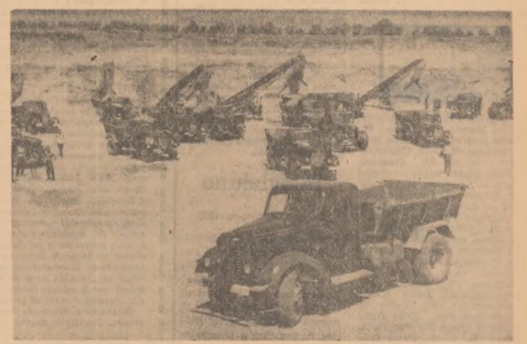
Din balastiera Bragadiru pleacă zilnic zeci și zeci de basculante (circa 2.500 m c) încărcate cu pietriș, nisip și balast necesar șantierelor de construcții din Capitală. Foto: AGERPRES
