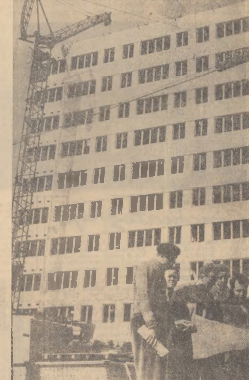
Șantierul „blocuri-gară” din orașul Bacău. Tovarășul inginer Teodor Lozincă, șeful șantierului, Gheorghe Jitaru proiectant și maestrul Lupu Gheorghe, împreună cu un grup de muncitori, discută despre ultimele lucrări necesare înisării.
