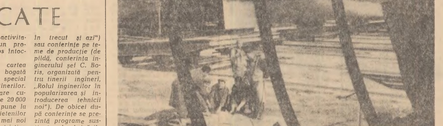
Pe calea de scos vase a Șantierului naval din Giurgiu se fac ultimele pregătiri înainte de începerea lucrului la bordajul unui șlep Foto: AGERPRES
