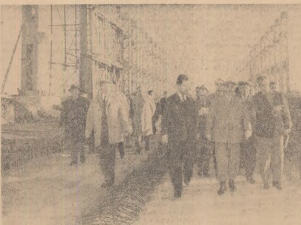
În vizită la șantierul Uzinei de aluminiu de la Slatina.
