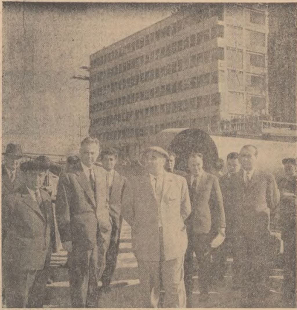
Vizitînd Centrala electrică de termoficare din Craiova.
