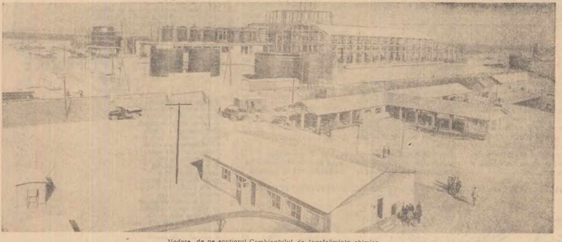
Vedere de pe șantierul Combinatului de îngrășăminte chimice.
