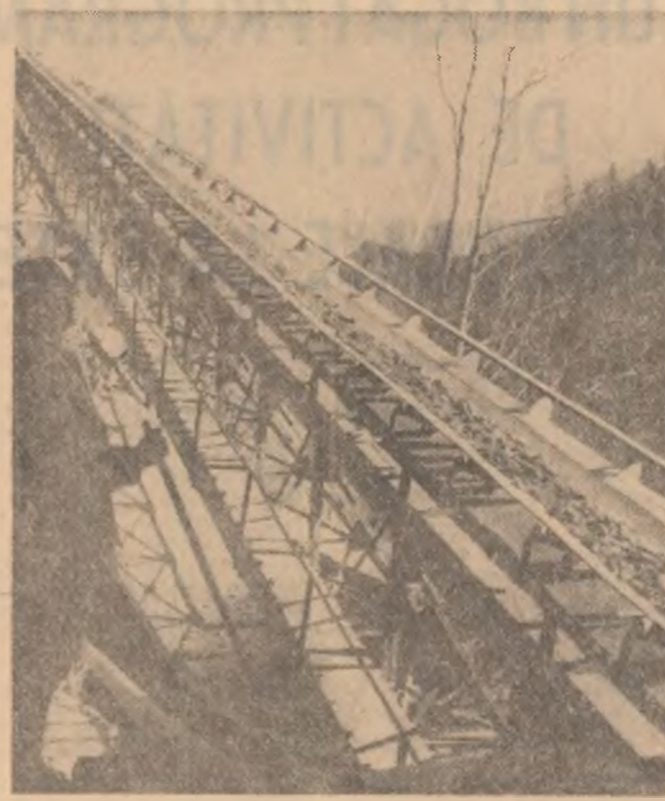
Aspect de muncă de pe șantierul Hidrocentralului „16 Februarie” din regiunea Argeș
