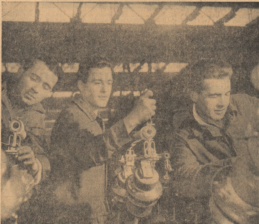
Tinerii Ion Dicu, Florea Draghia și Ștefan Chiriță din sectorul aparataj de lîne de la Uzinele „Electropulere” din Craiova, se numără printre muncitorii care obțin cu regularitate rezultate bune în întrecerea socialistă. Iată-i efectuînd ultimele verificări la siguranțele luzibile pentru stația de înaltă tensiune. Foto: O. PLECAN
