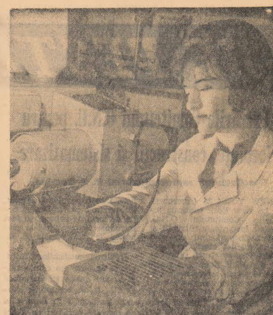
În laboratorul central al Ministerului Industriei Ușoare. Ing. Platon Maria Jeana, din secția chimică, execută analize de grad alb la aparatul „Ieucometru”.
