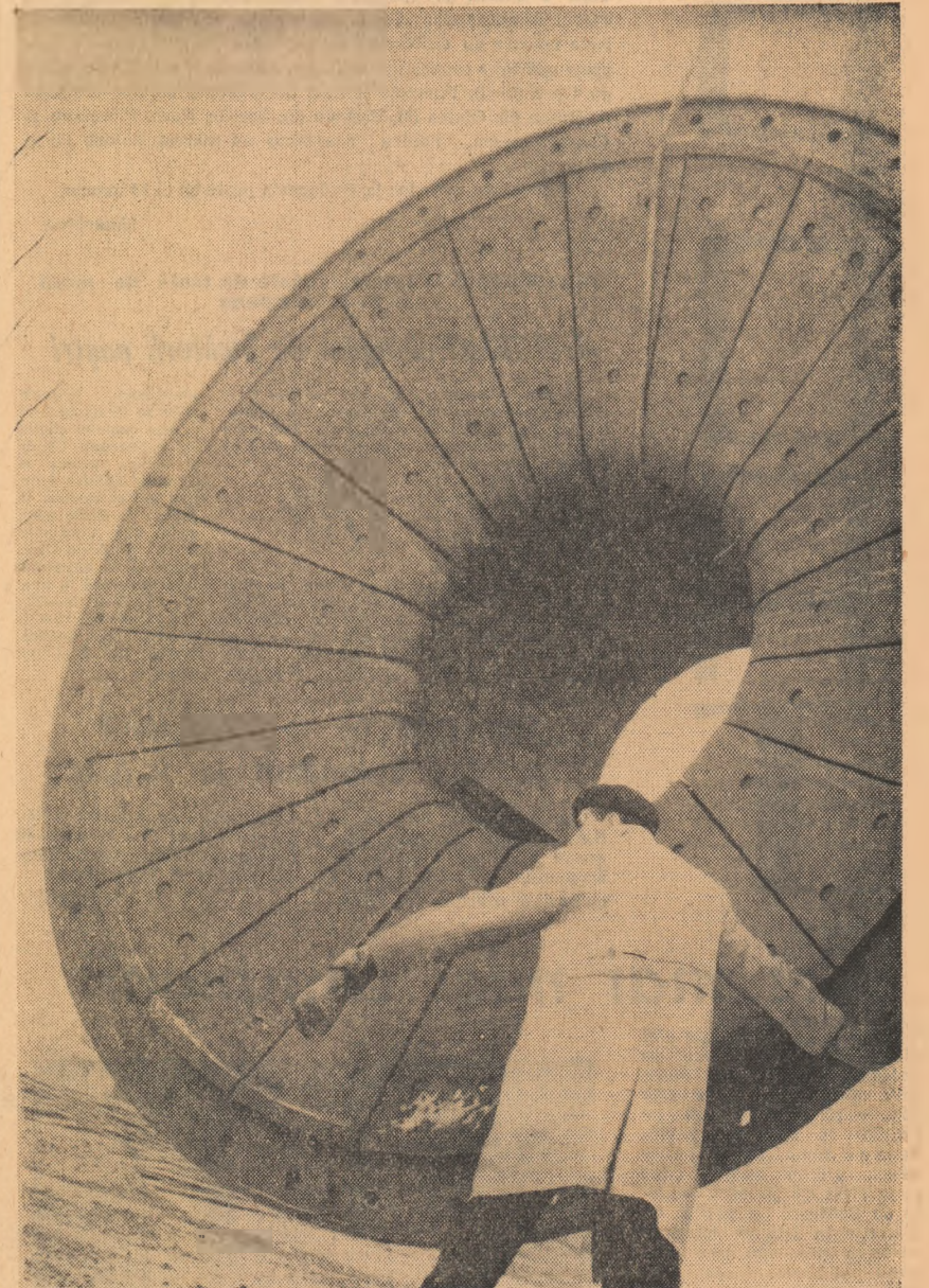
Pe șantierul Fabricii de ciment Tg. Jiu au sosit utilaje noi
