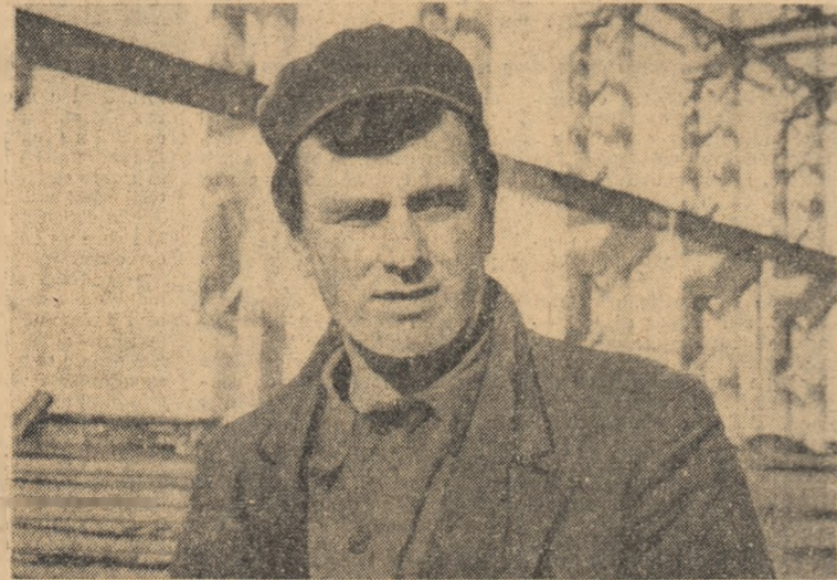
Chidu Gheorghe, lăcătuș montor, secretarul organizației U.T.M. montaj. A mai lucrat pe șantierul Govora, Săvinești, Craiova. Și pe lăcătuș din acele șantiere a absolvit o clasă la școala medie. Acum se pregătește pentru Institutul de construcții
