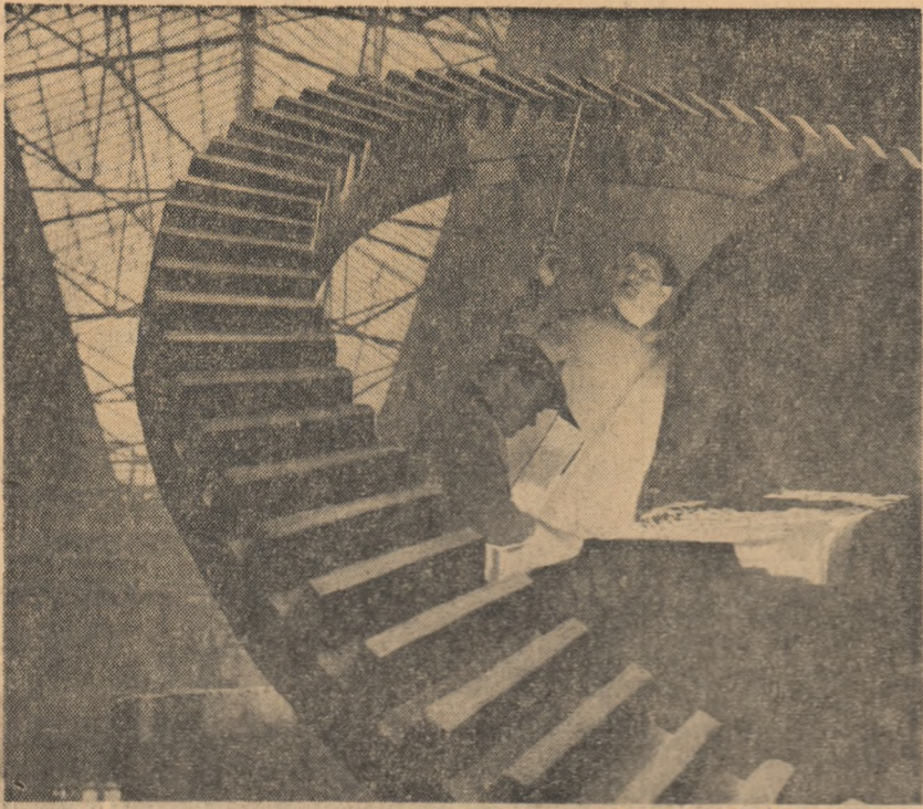
În secția turnătoriei de la Uzinele „23 August” din Capitală se toarnă roți dințate de mare tonaj. Măistrul Virgil Neacș și ajutorul Iordan Torna efectuează ultimele rețeluri la o astfel de piesă.
