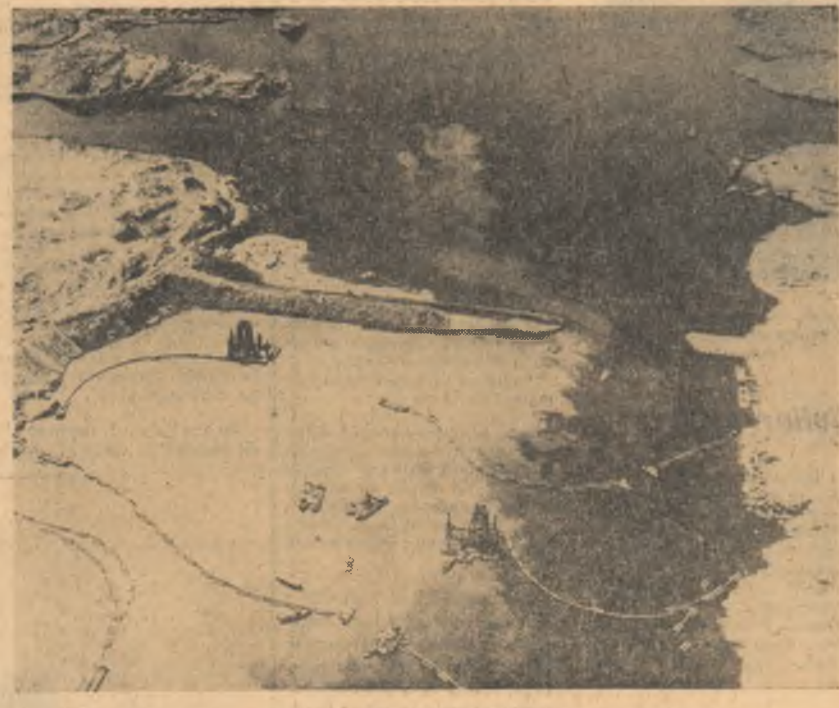
R.A.U.: Vedere din avion asupra șantierului de construcție al marelui baraj de la Assuan
