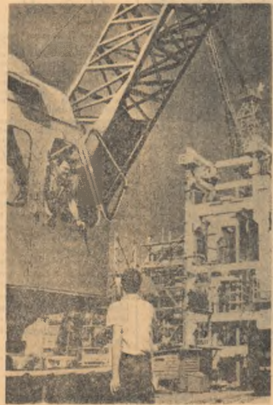
Aspect de pe șantierul de construcții al termocentralei „Maritima” din Cuba.
