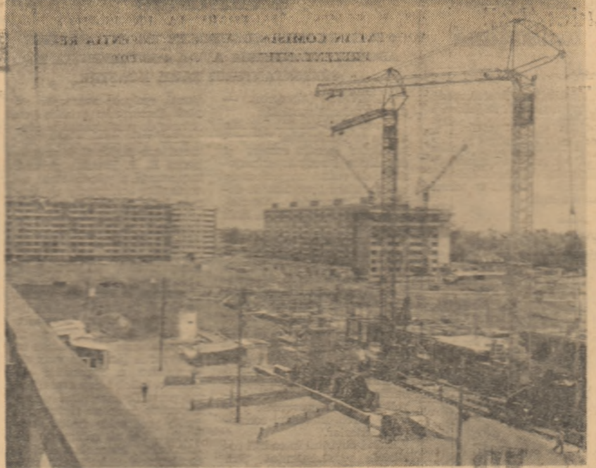
Noul locuințe în construcție în cadrul anamblului de locuințe nr. 2 — Drumul Taberei din Capitală.
