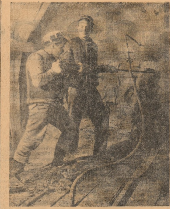
Aspect de muncă la una din minele de la Paroșeni
