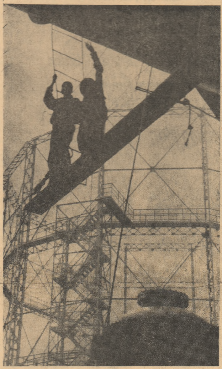
Pe șantierea Combinatului chimic de la Craiova Foto: N. STELORIAN
