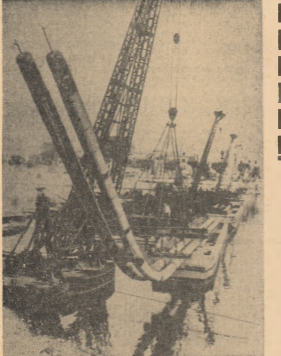
Lucrările de instalare a conductelor care vor transporta în Franța gaz natural sînt în curs. În cadrul acestor lucrări, au fost așezate în abia Senei două conducte lungi de oțel (212 metri fiecare) și cite două tone greutate. În fotografie: la Paris, pe șantierul de instalare a conductelor de gaze.
