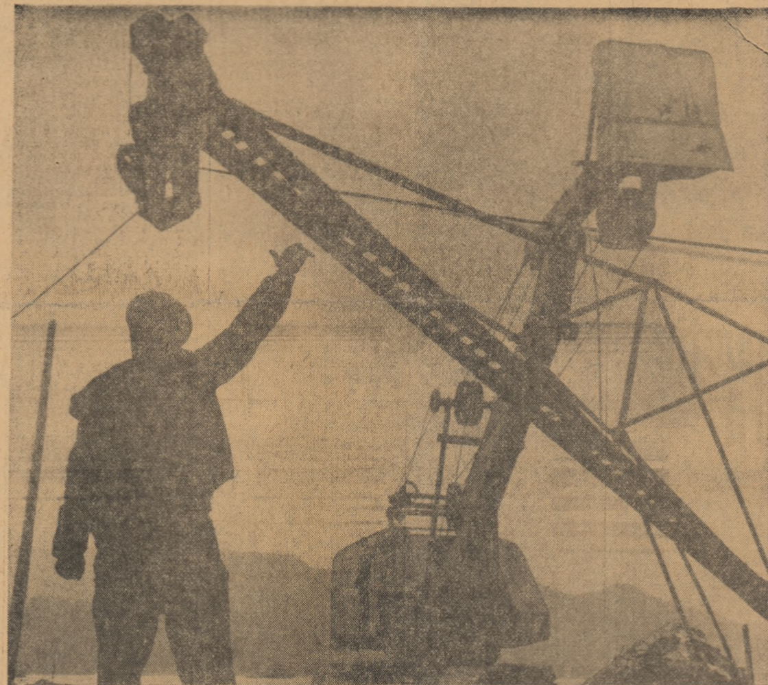
Un prim salu către zări, un prim semn al construcției: urioasa vibrosonodă electrică și-a început activitatea în zona viitorului batardou al barajului
