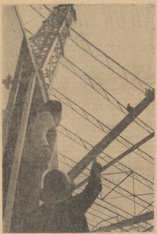
Construcțiile pe șantierul Combinatului siderurgic Galați înaintea din ritm susținut. În prim plan: Victor Lăzărescu și Vasile Dumitru executînd lucrări de montaj la un obiectiv. Foto: N. STELORIAN
