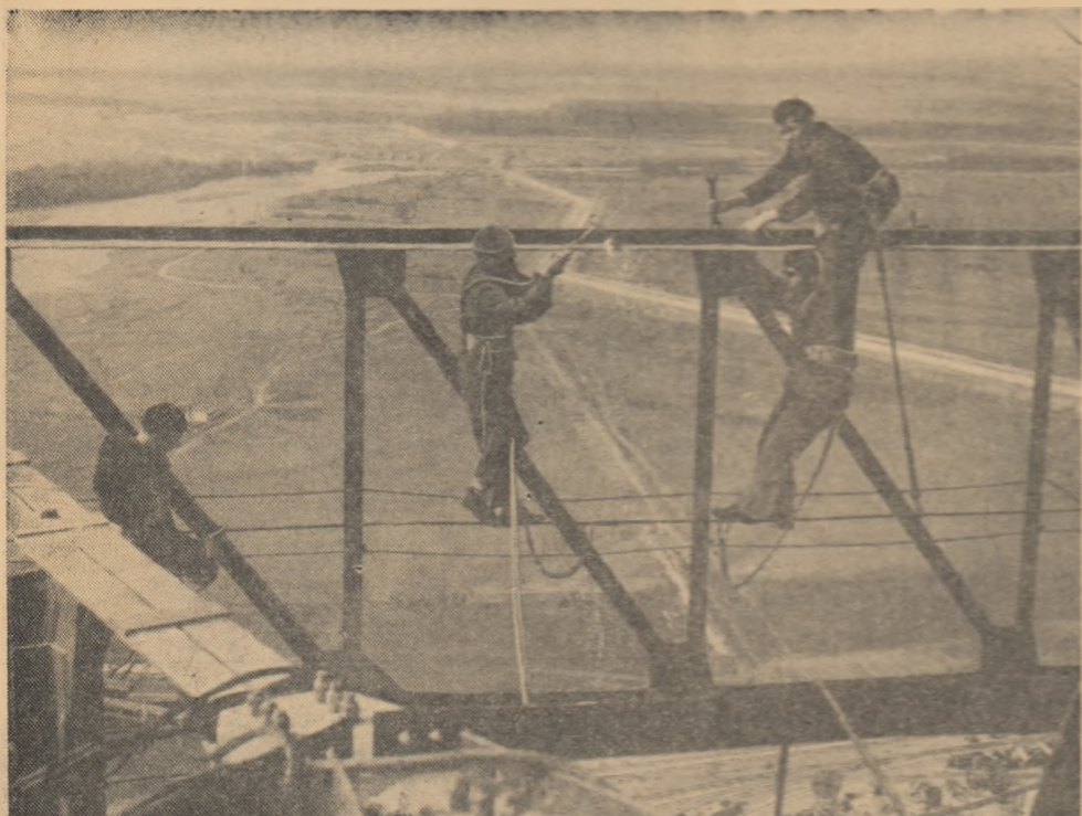
Termocentrala de la Ișlanița — Craiova. Montorii Virgil Baștin, Nicolae Mihai, Tudor Vasile și Mocanu Marin lucrând la copul de fum al hidrocentralei
